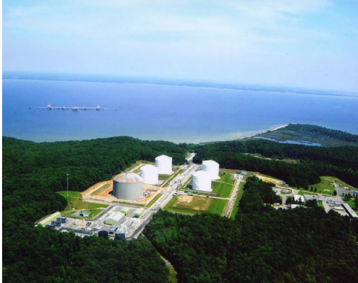
Dominion Cove Point LNG
