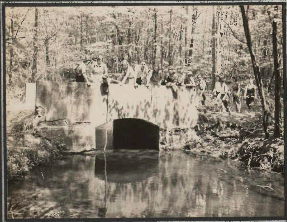
SEGLOCK RUN BRIDGE
